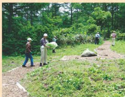
夢見平遊歩道の整備の様子。守る会によって、完成後も定期的にメンテナンスされている。
